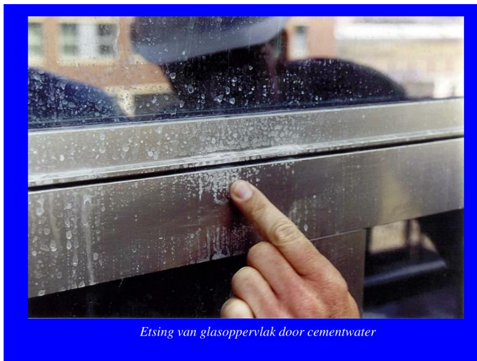
Figuur 25 — Etsing van glasoppervlak door cementwater
