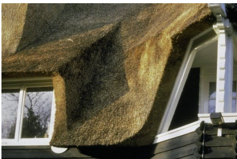
Figuur 51 — Voorbeeld van verschillende hellingshoeken in een rieten dak (Bron: https://www.dakdek-gigant.nl/dak-vernieuwen/rieten-dak/ )
