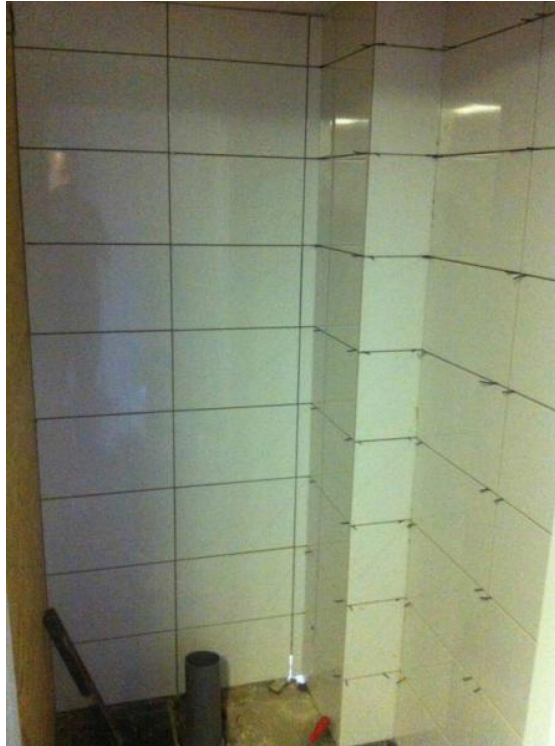
Figuur 16 — Een voorbeeld van onjuist, dat wil zeggen asymmetrisch aangebrachte tegels (Bron: https://www.mijnzzp.nl/Beroep/120-Tegelzetter/Informatie )
