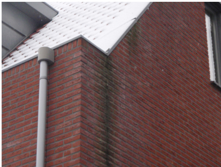
Figuur 37 — Voorbeeld van vervuiling door slechte detaillering (Bron: privéarchief van voormalig bouwkundig adviseur bij Woningborg)
