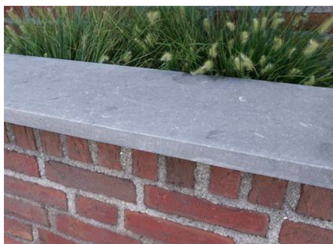
Figuur 46 — Een waterdichte muurafdekking kan witte uitslag voorkomen
