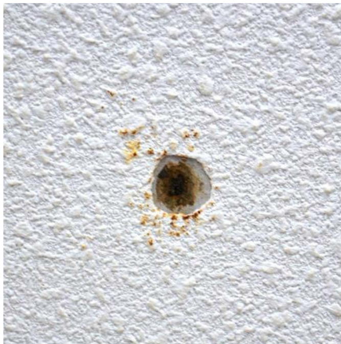
Figuur 23 — Pop-out, roestvlek ontstaan door een stuk verontreiniging in het beton (Bron: https://www.werkspot.nl/opdracht/1297705/betonrot-of-roestend-vlechtwerk-behandelen )
