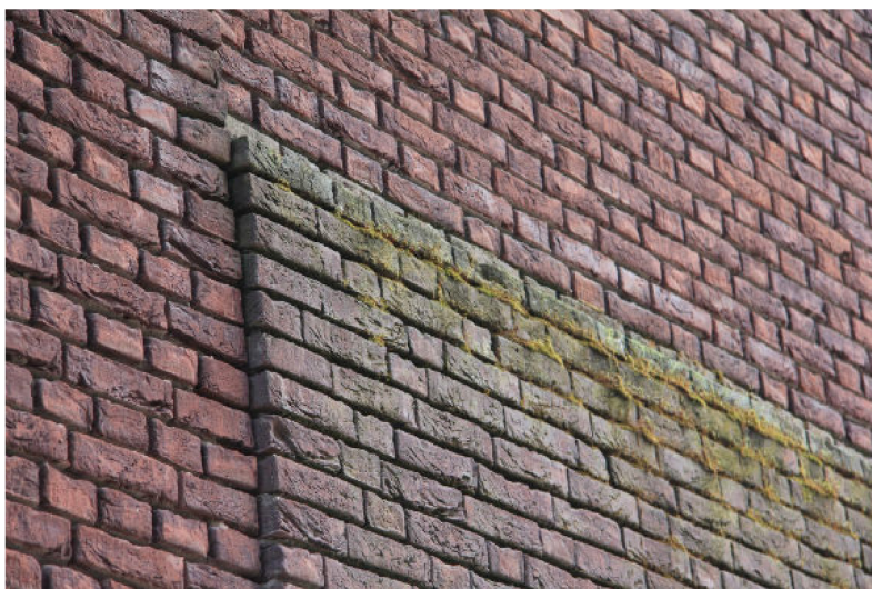
Figuur 40 — Voorbeeld van uitspringend metselwerk wat groen wordt door alg- en mosvorming als gevolg van waterbelasting
