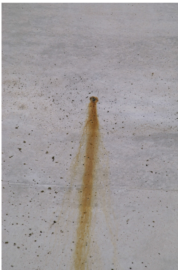
Figuur 23 — Pop-out, roestvlek ontstaan door een stuk verontreiniging in het beton (Bron: https://www.werkspot.nl/opdracht/1297705/betonrot-of-roestend-vlechtwerk-behandelen )
