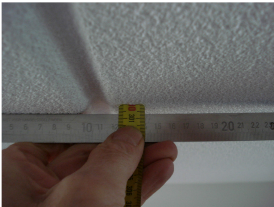
Figuur 19 — Voorbeeld van zichtbaar hoogteverschil van 7 mm
