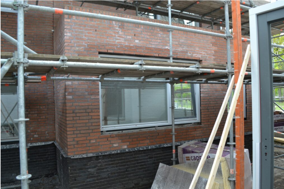
Figuur 36 — Verkleuring van het metselwerk door regen
