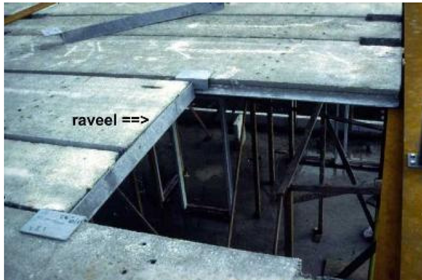
Figuur 20 — Raveelijzer bij trapgat
