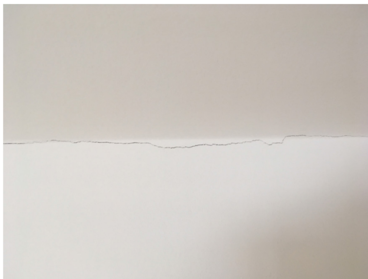
Figuur 29 — Voorbeeld van een seur in het stucwerk
