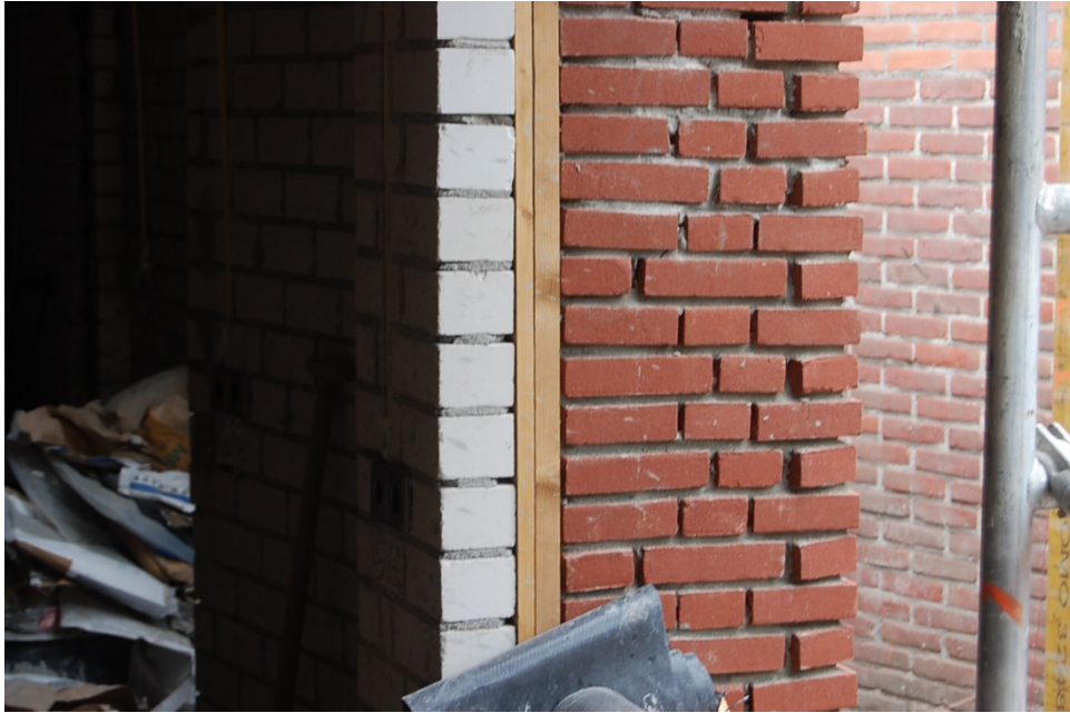
Figuur 35 — Metselwerk 'uit de losse pols'
