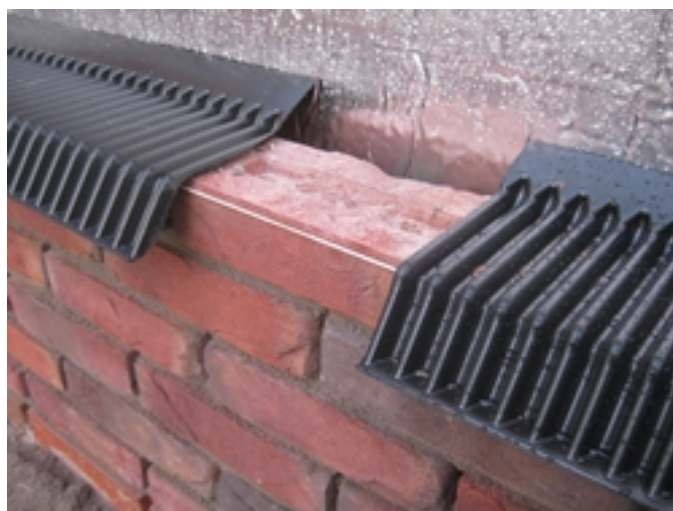
Figuur 45 — Vers metselwerk afgeschermd tegen regen
