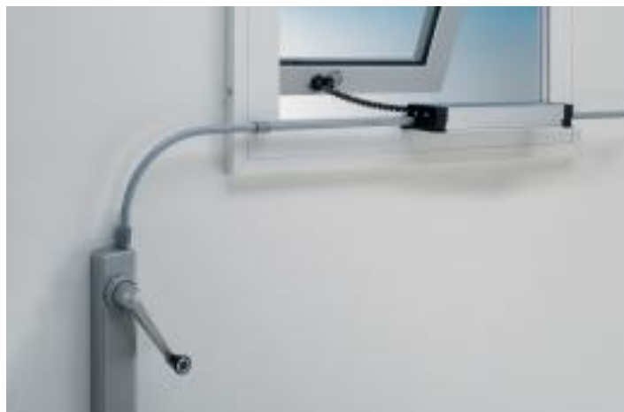
Figuur 52 — Voorbeeld van een mogelijke oplossing bij te hoog geplaatste bediening (Bron: https://www.amerflex.nl/ )
